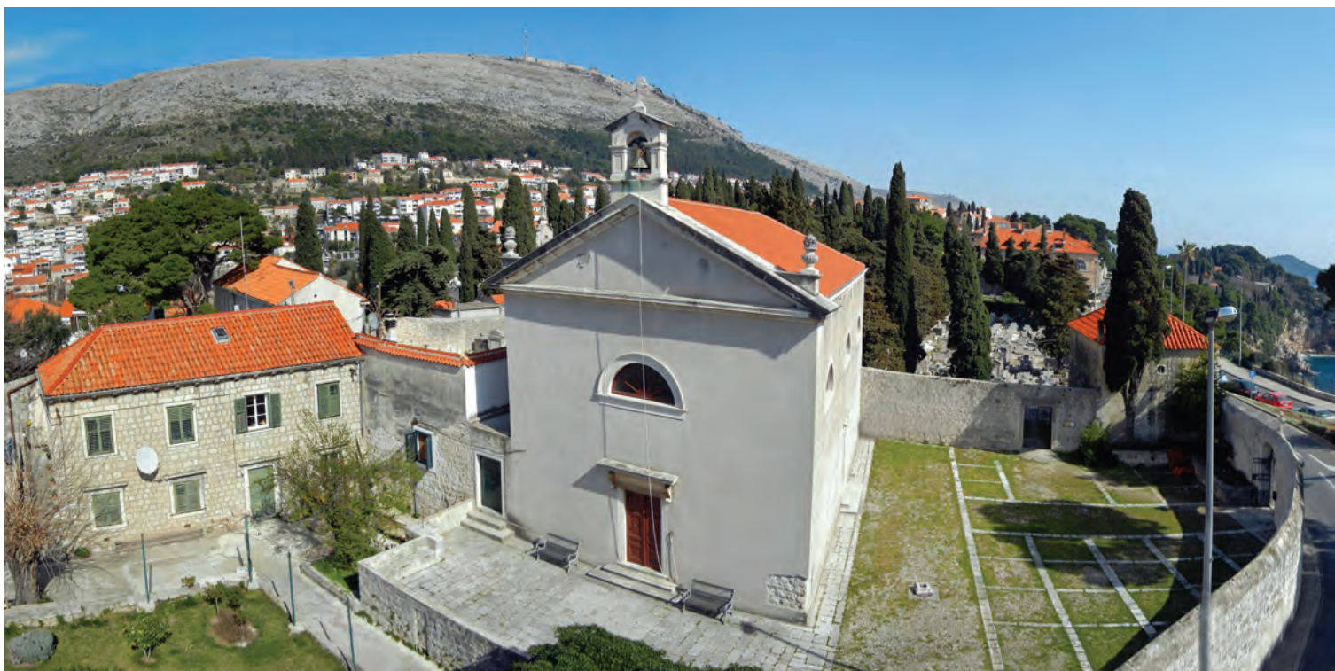
II/8 – Поглед на Цркву Св. арханђела Михаила на Бонинову. Кућа с леве стране цркве, у власништву Српске православне црквене општине, служи за становање црквењака и чувара гробља; десно од цркве унутрашње двориште са улазним вратима у гробље
